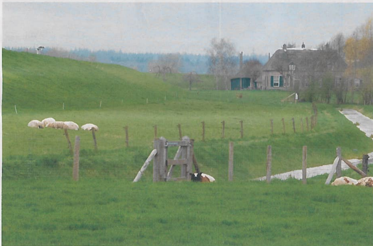
De Ijsseldijk in de buurt van Herxen. De dijk wordt tussen 2023 en 2026 verstevigd.
